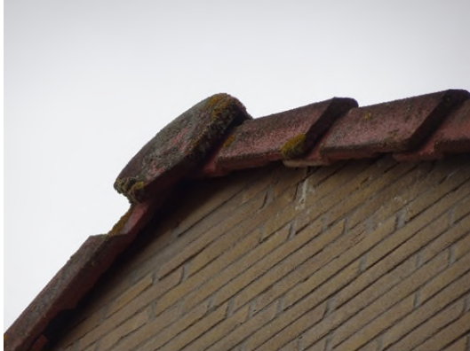
Figuur 3.4 Voorbeeld van overstekende kantpannen en nokpan.
