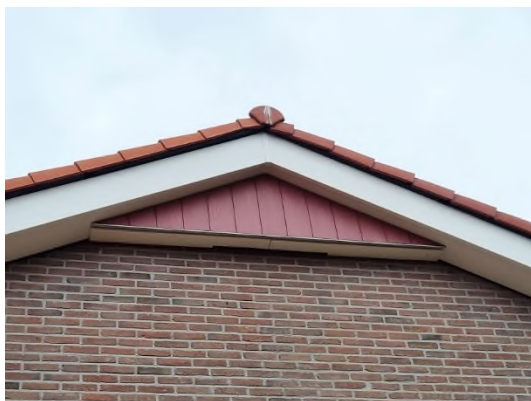
Figuur 3.7 Gevelbetimmering voor vleermuizen (Unitura, 2023).
